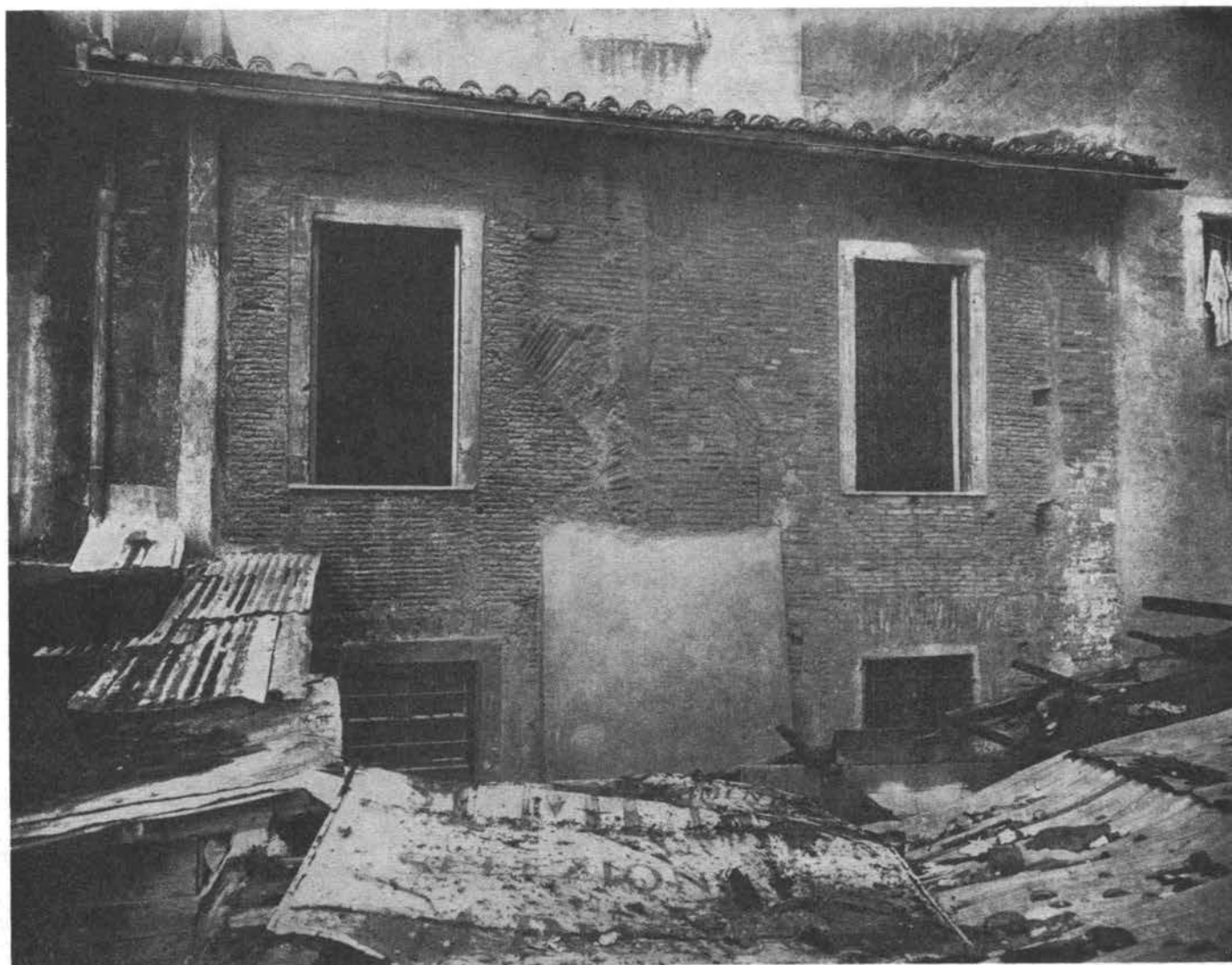
Fig. 6 — S. AGATA IN TRASTEVERE — Muro dell'antica struttura.
